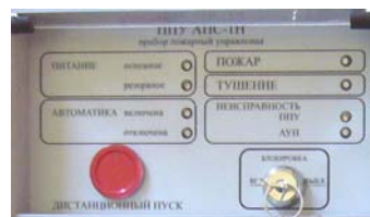
Рисунок 5 Внешний вид прибора пожарного управления.
